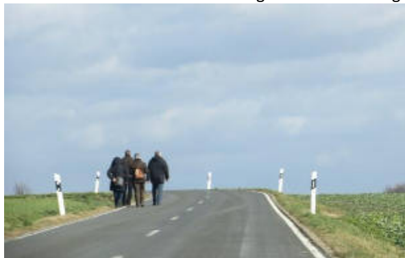
Abb. 70: Außerortsstraße ohne begleitenden Gehweg
