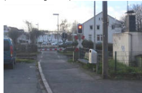
Abb. 164: Bahnübergang für Fußgänger zw. Markt/Fußgängerzone und Rathaus (Blickrichtung Süden)
