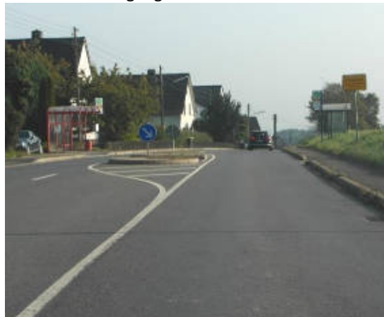
Abb. 31: Ortseingangssituation in Ostbüren
