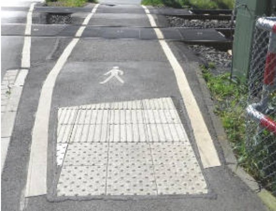
Abb. 71: Taktile Elemente am Bahnübergang Alleestraße/Westicker Straße
