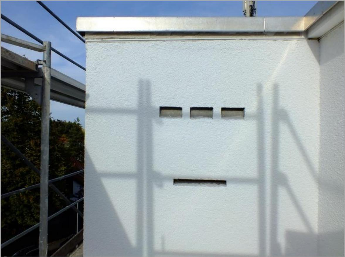
**Abbildung 16: Fledermausquartiere: In eine Außenfassade eingebaute Hohlblocksteine.**
