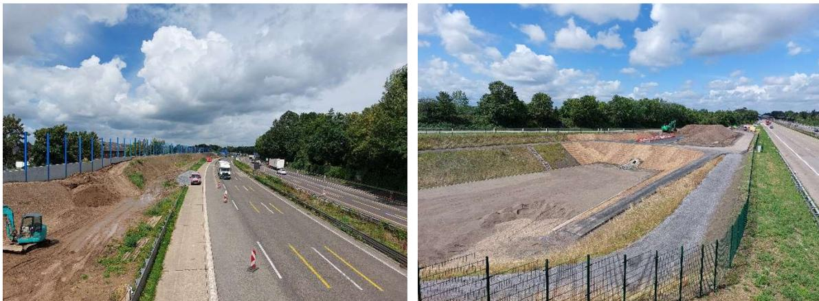
Abb. 31: Baumaßnahmen Lärmschutzwand Detmolder Straße und Versickerungsbecken Süd (eigene Bilder, August 2023)
