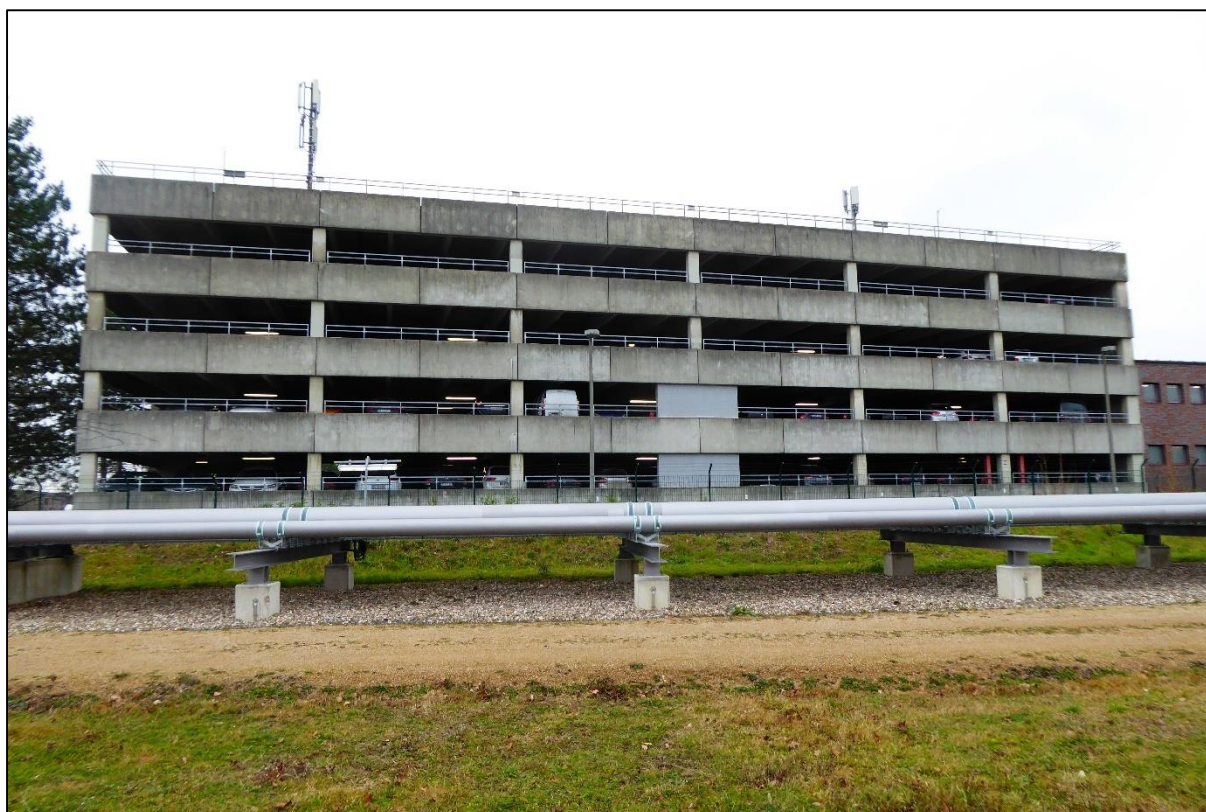
Abbildung 19: Das Parkhaus weist an der Fassade Spalten zwischen den Betonplatten auf, welche von Zwergfledermäusen als Quartier genutzt werden könnten.
