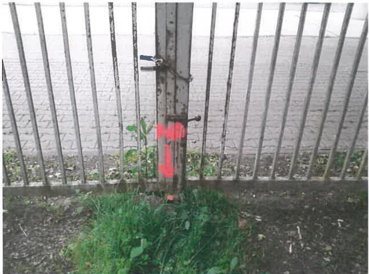
**Foto Anhang 7** - Eingangstor des Friedhofes zur Hubertusstraße: Bezugspunkt für das von uns durchgeführte Nivellement (farblich markiert)
