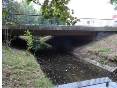
Massive Ufersicherung der Horne unter Brücke Hansaring mit anschließender grasgeprägter Profilböschung
