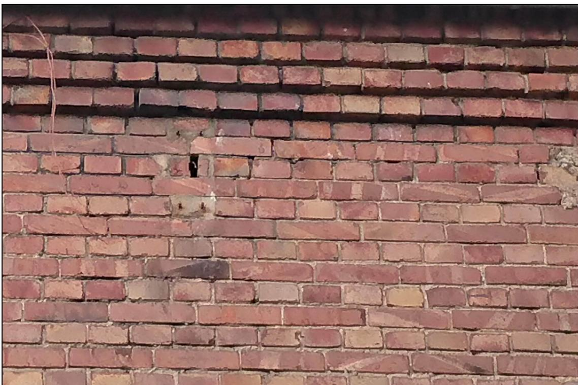
**Abb. 6: Loch in der Klinkerfassade mit Hohlraum**
