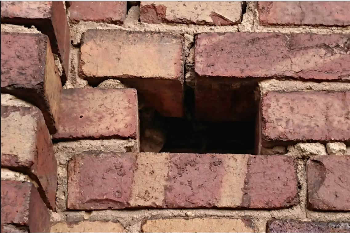
**Abb. 7: Loch in der Klinkerfassade mit Hohlraum**
