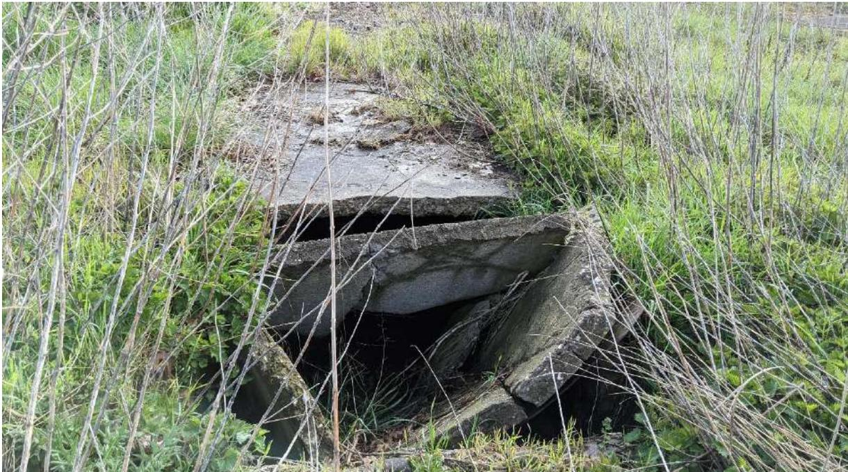
Abbildung 9: Betonierte Hohlräume
