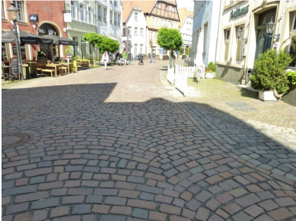
Abbildung 2: Foto Emsstraße mit Blick Richtung Norden, Großpflaster
