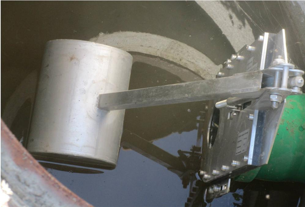
Abb. 7: Drossel für eine konstante Wasserableitung
