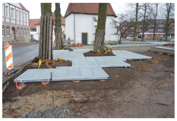
Abbildung 3: Wurzelbrücken aus einer Stahlrohrkonstruktion, Quelle https://humberg-baumschutz.de/wurzelschutz-bruecken-radix
