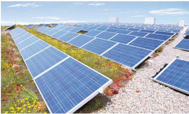
**Dachbegrünung mit Photovoltaikmodulen (Quelle: OPTIGRÜN 2010)**
