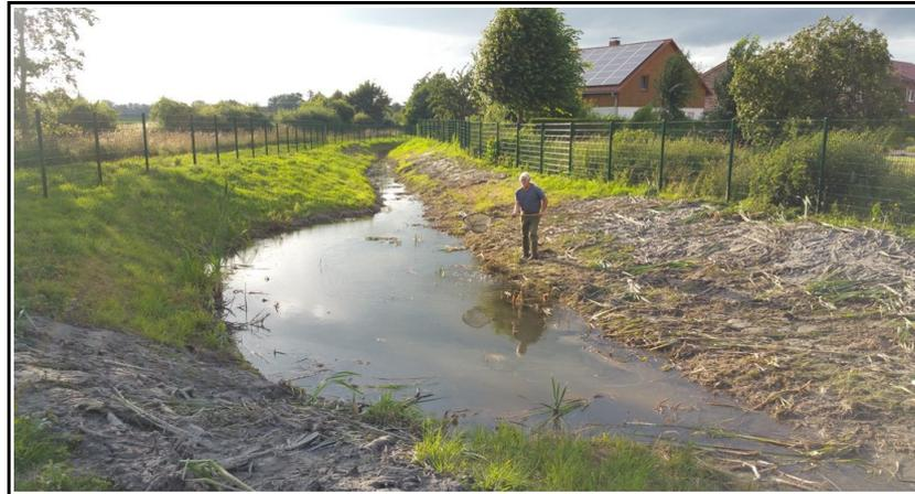
**Abb. 3.1: Blick auf einen Teil des Regenrückhaltebeckens**
