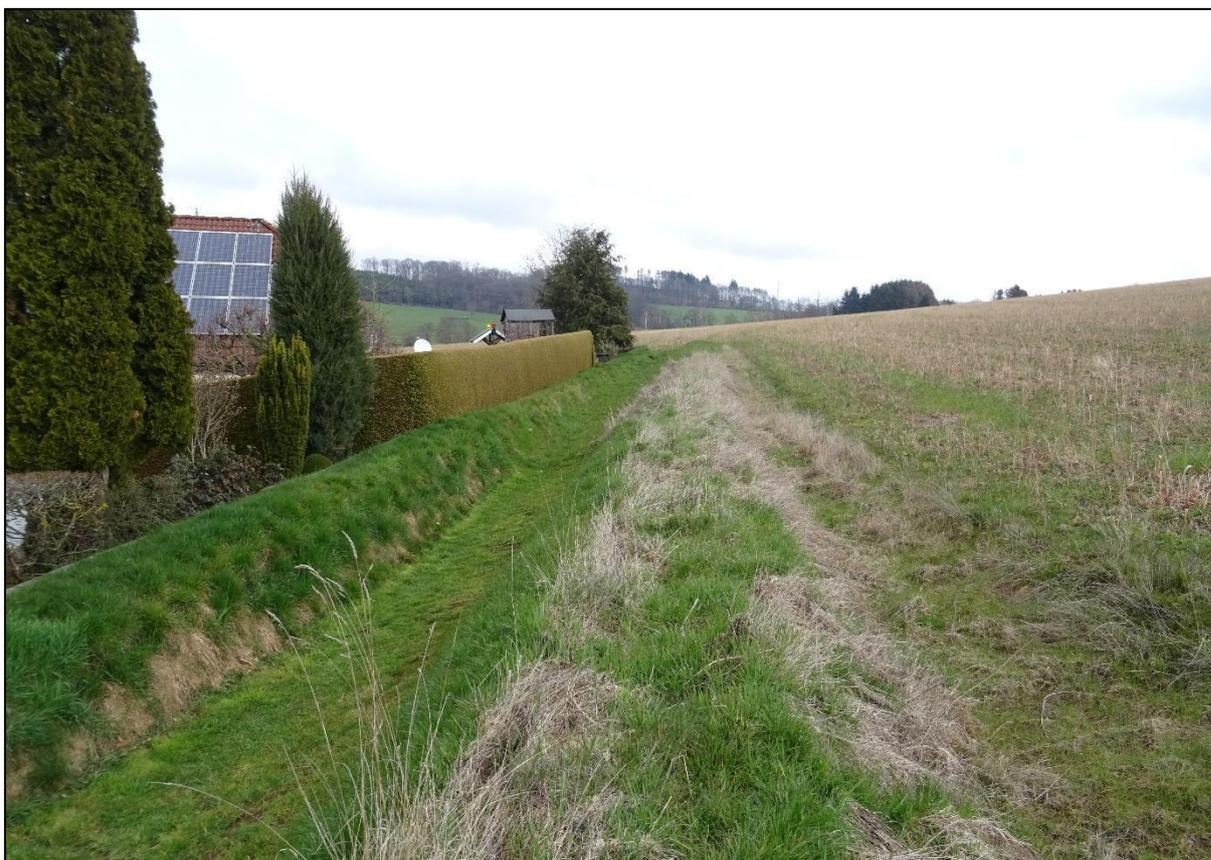
Abbildung 7: Doppelter Wall als Erosionsschutz bei Starkregen im Westen des Plangebietes (Blickrichtung Nordosten).
