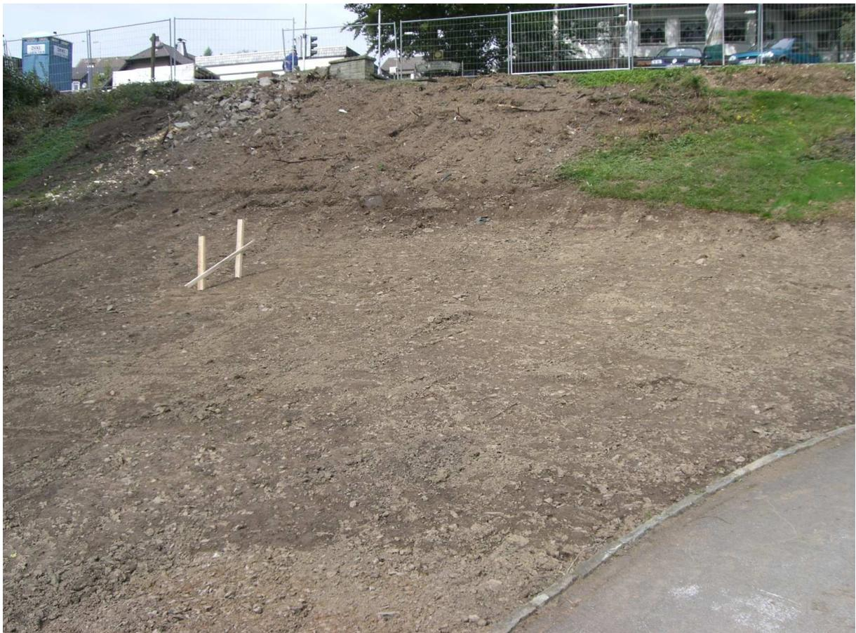
Bild 5: Profilierung der Böschungen für den Geh-/Radweg und die Blütenkaskade
