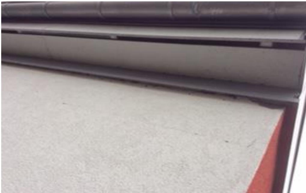
Bild 1: Dachanschluss in kompakter und dichter Bauweise. Die Längsspalten unterhalb der Dachrinne sind mit feiner Gaze verschlossen.
