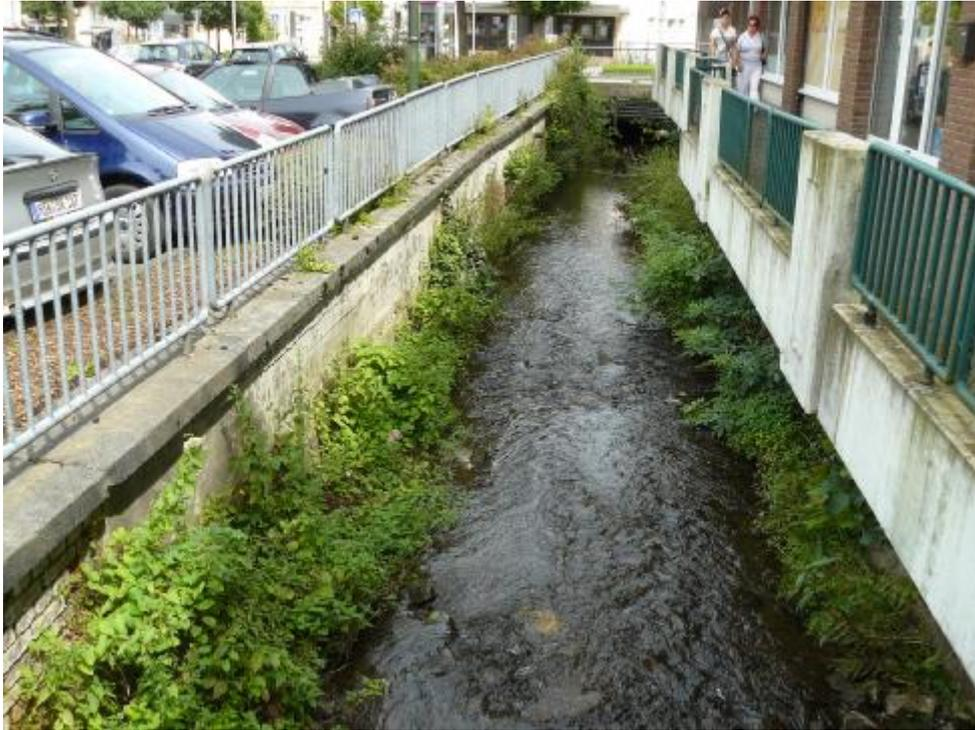
**Abb. 31:** Durch eine Profilaufweitung im linken Uferbereich (hier in Fließrichtung gesehen) kann der Settmecke Abschnitt eine schmale Ersatzauze erhalten, die ökologisch hinsichtlich naturnaher Gewässerprofile wirksam ist und gleichzeitig die Zugänglichkeit des Gewässers und damit seine Erlebnisqualitäten fördert – eine entsprechende Planung hängt davon ab, wie viel Platz dem Gewässer linksseitig im Rahmen weitergehender städtebaulicher Überlegungen zur Verfügung gestellt werden kann.
