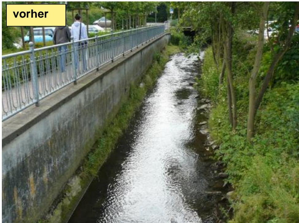
Abb. 17: Röhrverlauf begradigt und strukturell verarmt oberhalb des Levi-Klein-Platzes
