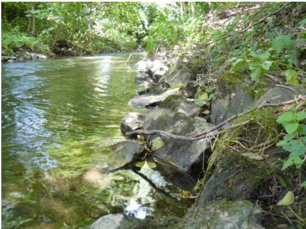
**Abb. 25:** Innerhalb des Erlenwäldchens ist die Röhr – wie auf der gesamten Strecke des Planungsraumes – durch Steinschüttungen fixiert
