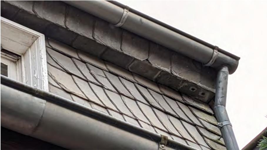
Abb. 2: Einschupfmöglichkeiten im Bereich der Verkleidung
