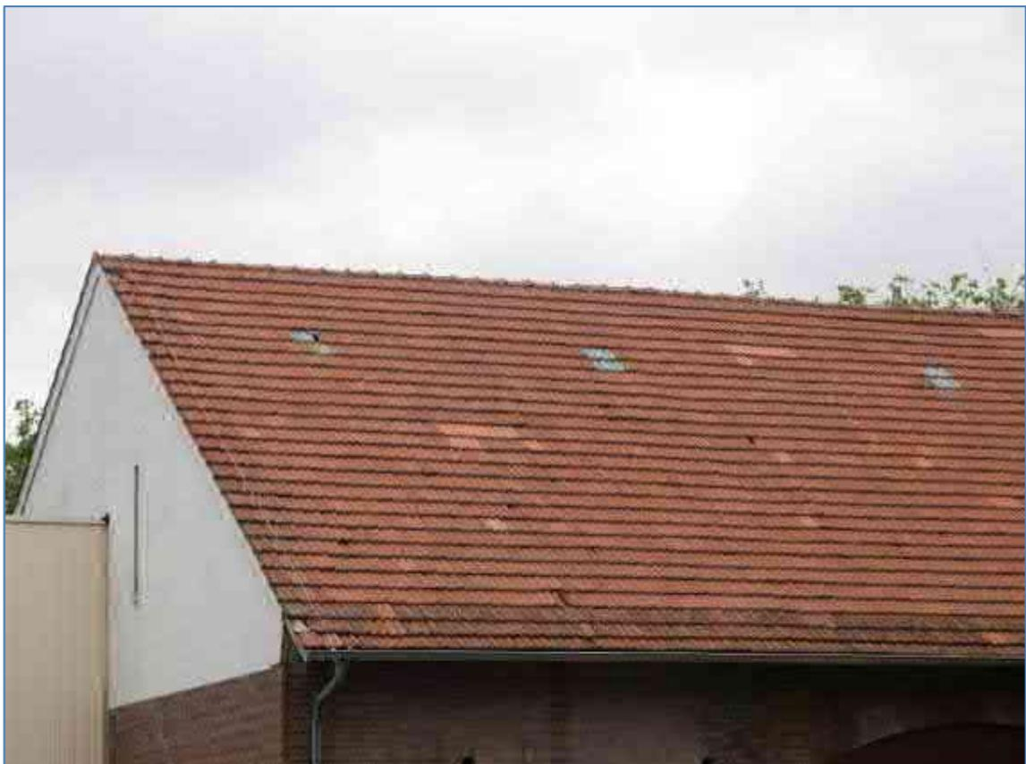
Abb. 16: Gebäude E - defekte Dachziegel.
