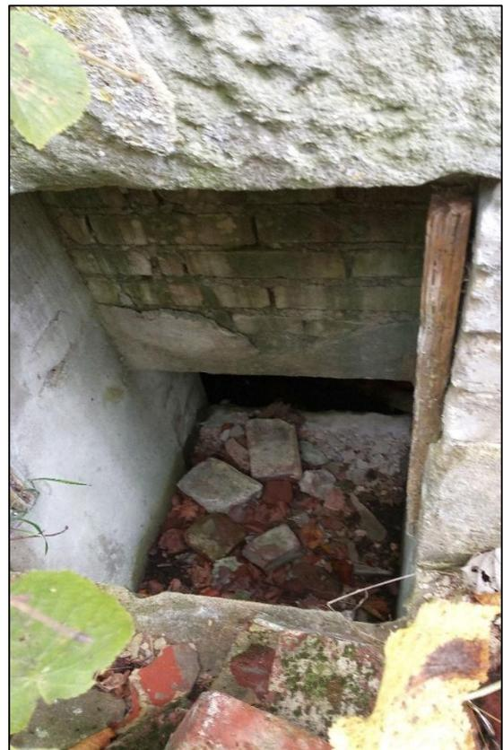
**Foto 3:** Kellerloch (Zugang zum Keller), Wasserstand bis knapp unter Decke
