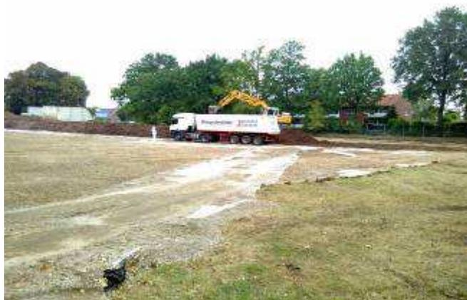
**Bild 9** (27.09.18): Verladung des aufgehaldeten Kieselrots.
