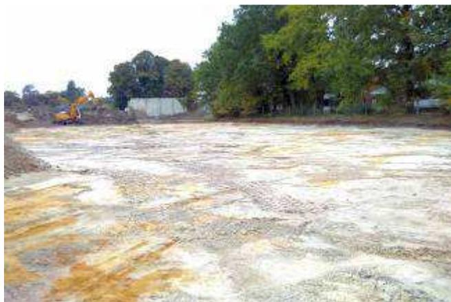
**Bild 19** (04.10.18): Blick über die Sanierungsfläche nach Nordwesten. Kieselrot und Schottertragschicht sind vom nördlichen Teil des Sportplatzes zu diesem Zeitpunkt entfernt.
