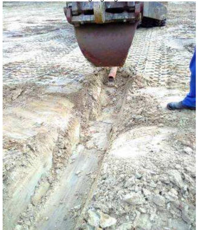
**Bild 34** (24.10.18): Ausbau der Dränageleitungen inklusive des Dränkieses unter Aussonderung der teerhaltigen Dichtbahn.
