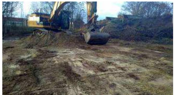
**Bild 56** (03.12.18): Restabtrag in Teilfläche I – Der Aushub erfolgte bis auf den hellbraunen Sand an der Basis des Oberbodens.
