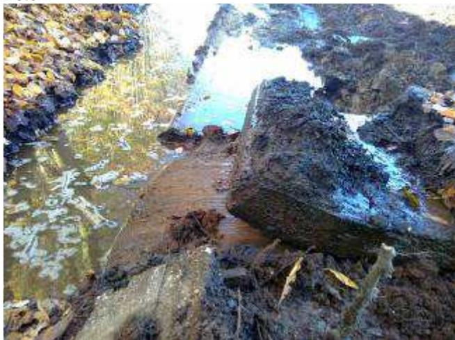
**Bild 39** (15.11.18): Rückbau der Betonplatten des Bachgerinnes inklusive der Kieselrotschüttung unter dem Beton.
