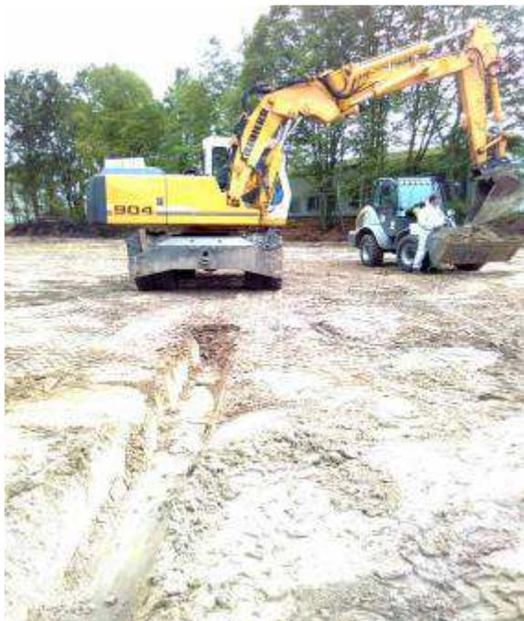
**Bild 35** (25.01.18): Ausbau der Dränageleitungen inklusive des Dränkieses unter Aussonderung der teerhaltigen Dichtbahn.
