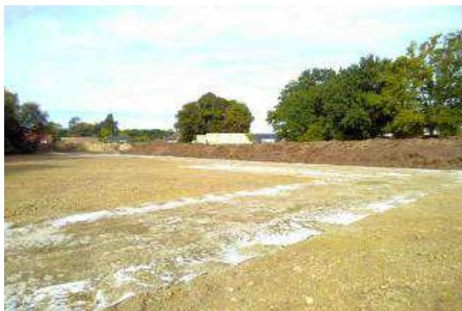
**Bild 8** (26.09.18): Freigelegte Schottertragschicht des Sportplatzes mit der Lagerhalde des abgezogenen Kieselrots im Hintergrund.
