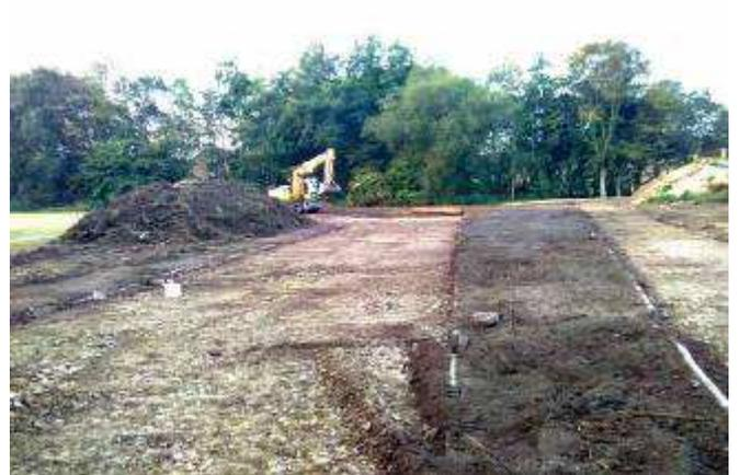
**Bild 2** (20.09.18): Freilegen der Weitsprunganlage und des Wegs an der Westseite des Sportplatzes – Abtrag der Kieselrotdecke.
