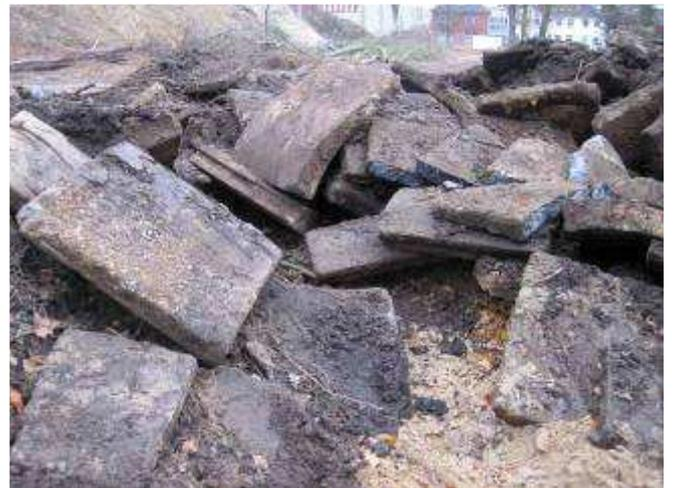
**Bild 48** (21.11.18): Betonplatten aus dem Bachgerinne vor der Verladung.
