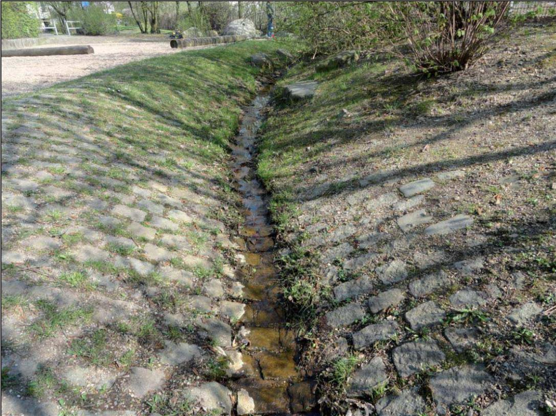
Abb. 3: Sandbach mit befestigter Bachsohle und- ufern
