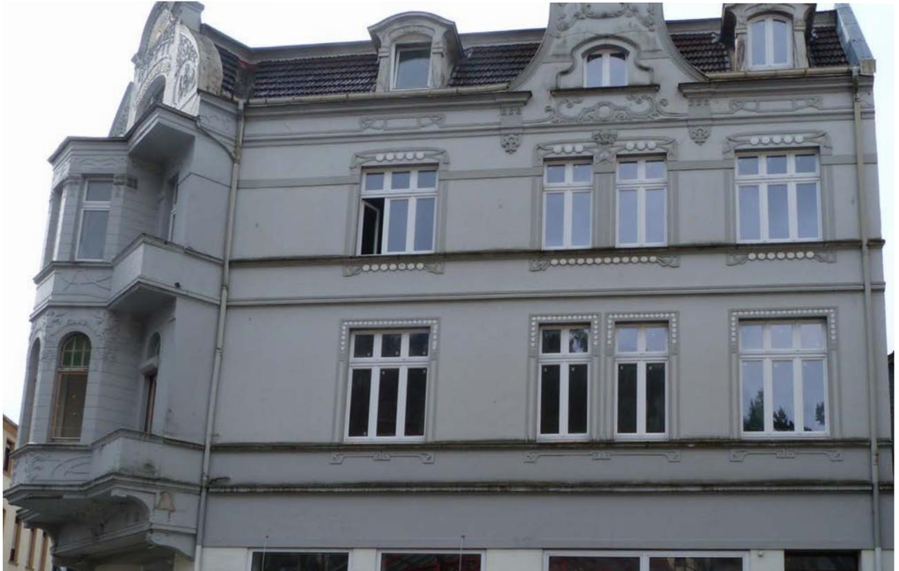
**ABB 043** Gliederungselemente erhöhen die Plastizität der Fassade
