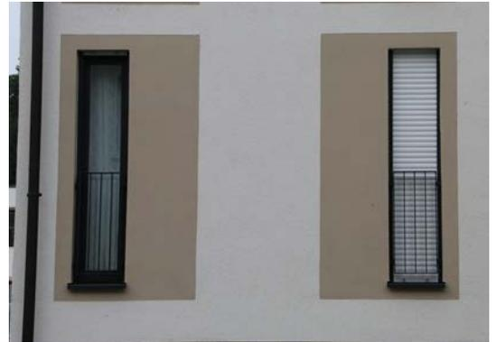
**ABB 042** Betonung von Öffnungen im Neubau durch Faschen
