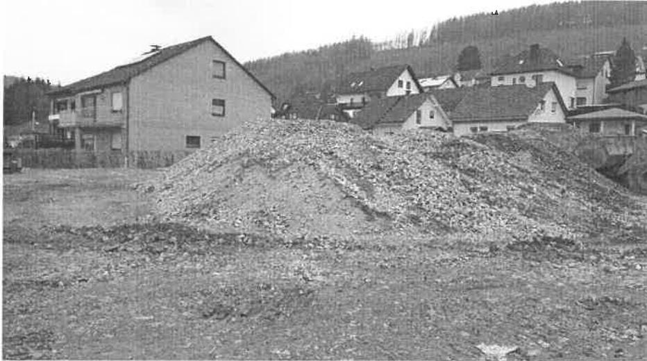
Abbildung 1: gebrochener Bauschutt seitlich gelagert
