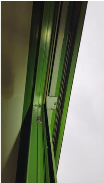
**Abbildung 12:** Offener Rollokasten ohne Lamellen.
