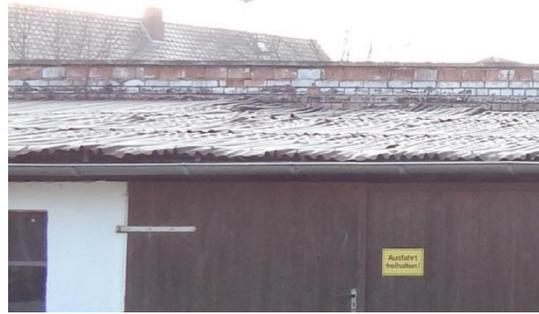
**Abb. 23 Dachabdeckung aus Bitumenwellplatten.**
