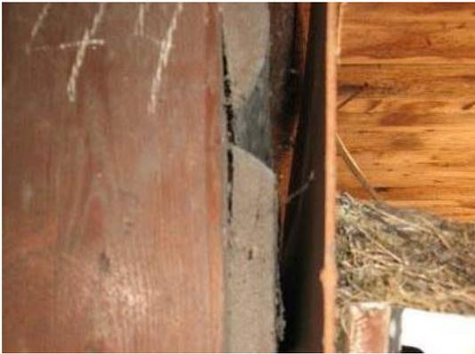
**Abb. 45 Spalt in der Zwischenwand.**
