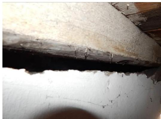
**Abb. 29** Spalt im Übergangsbereich von Mauerwerk zu Dachbalken.
