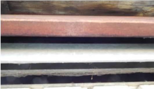
**Abb. 22 Spalt im Übergangsbereich von Mauerwerk zu Dach.**
