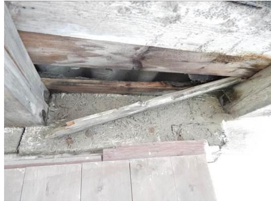
**Abb. 27** Einflugmöglichkeit durch den Raum zwischen Welldach und Vertäfelung.
