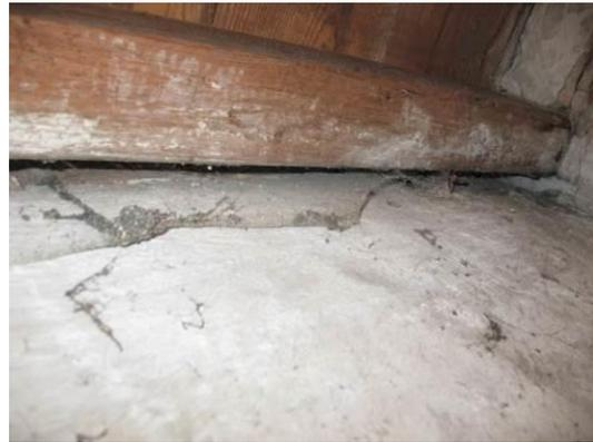
**Abb. 46 Spalt zwischen Dachbalken und Mauerwerk.**
