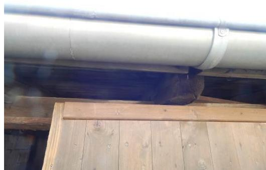
Abb. 21 Einflugmöglichkeit am Tor.
