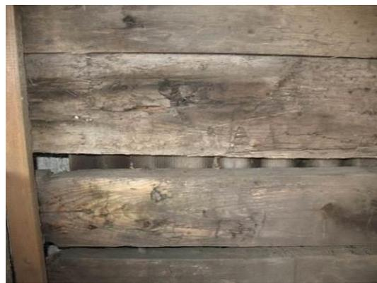
**Abb. 40** Spalt zwischen Holzvertäfelung und Wellverkleidung.
