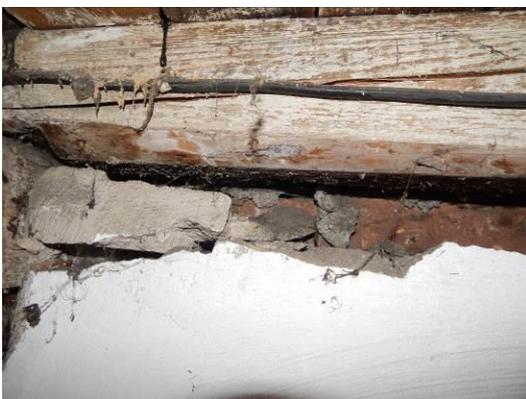
**Abb. 28** Spalt im Übergangsbereich von Mauerwerk zu Dachbalken.
