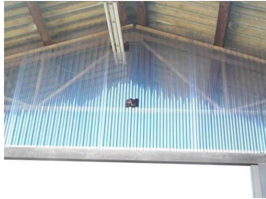
**Abb. 32 Einflugmöglichkeiten in der Giebelverkleidung.**
