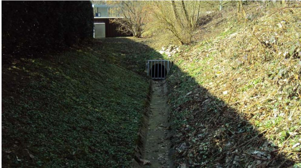
Abbildung 2: Einlaufbauwerk des Regenwasserkanals
