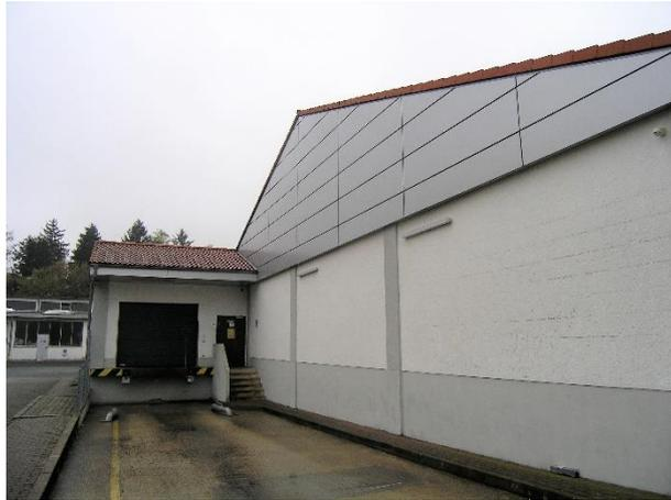
**Foto 2: Fassadenverkleidung aus Metall**
