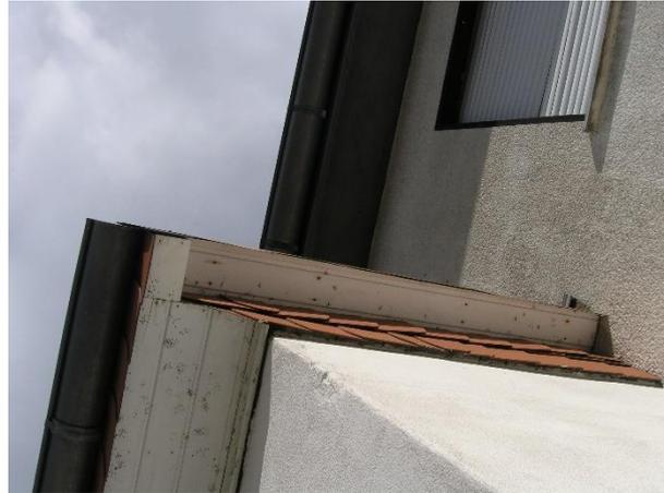
**Foto 10:** Anbau mit Eternitverkleidung und Holztraufkasten
