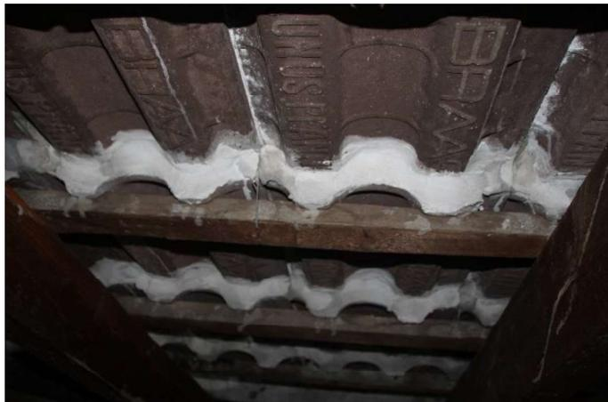
**Foto 14: Durch Spachtelmasse verschlossene Dachziegelüberlappungen**
