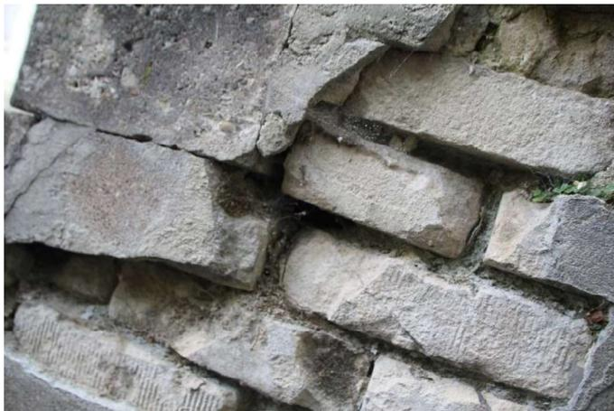
**Foto 18: Beschädigungen am Putz der Außenfassade mit Potential für Fledermausquartiere**
