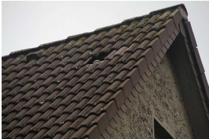
**Foto 13: Einflugmöglichkeit in den Dachboden durch einen fehlenden Dachziegel**
