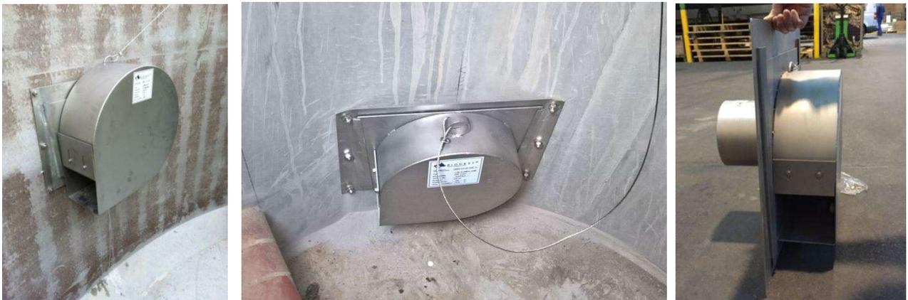
Ausführung mit Montageplatte an gerader Wand (l), im Rundschacht (m) und für Rohrabgang (r)
