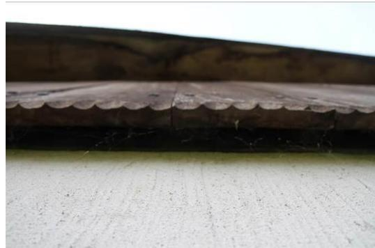
**Abb. 40** Spalt im Übergang von Fachwerk zu Giebelverkleidung.
