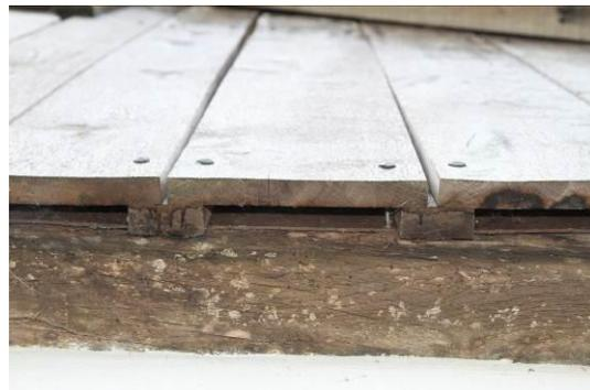
**Abb. 38** Spalt im Übergang von Fachwerk zu Giebelverkleidung.
