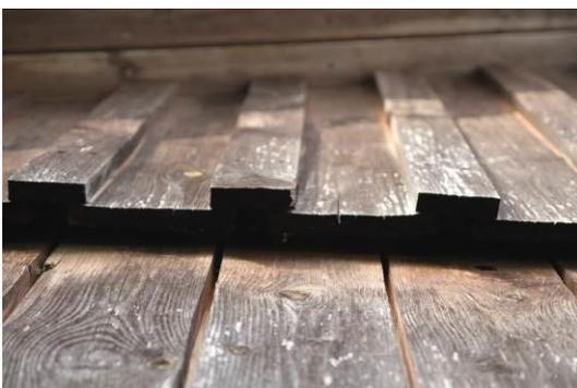
**Abb. 43** Spalt in der Überlappung der Verkleidung.
