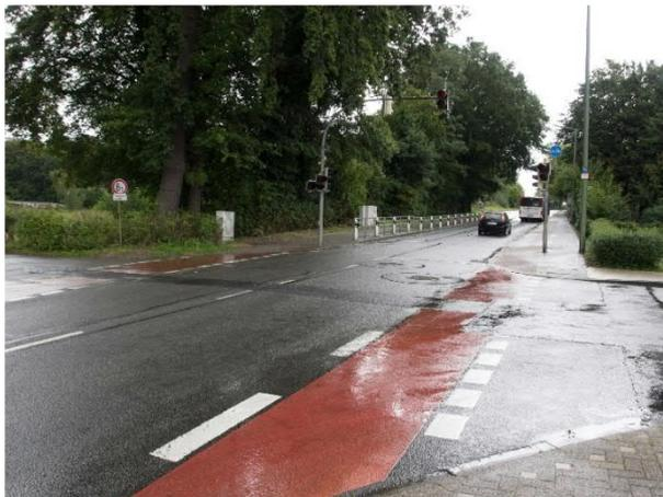
Abb. 19 Querung Radverkehr wird durch Rotmarkierung verdeutlicht, Querung Meller Landstraße wird über eine Bedarfs-LSA gesichert
