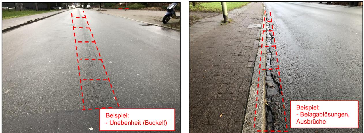
Abbildung 13: Streckenschäden – Beispiele; Annahme: 1 m Streckenschaden entspricht einem Einzel Schaden
