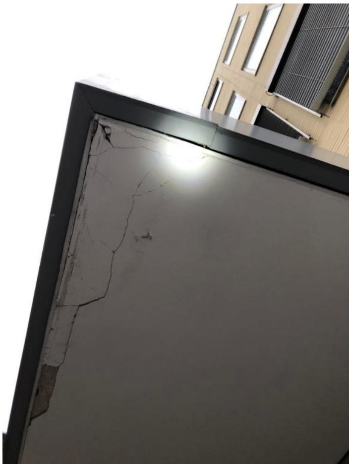
Abb. 3: Südliche Ecke, Vordach mit Öffnung in der Dachkonstruktion
