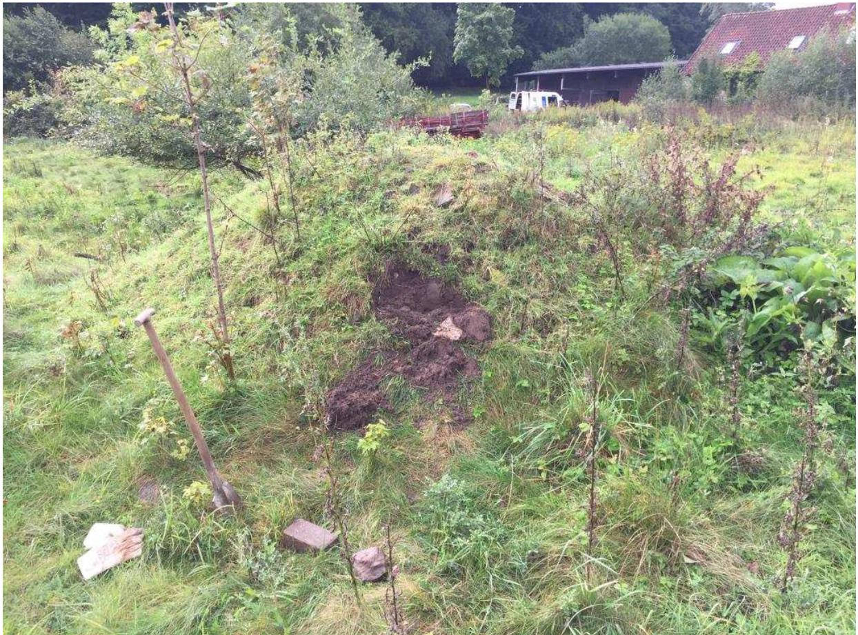
**Abb. 4 (13.09.2017):** Bodenhauferke 1 aus dem die Mischprobe MP Haufwerk 1 entnommen wurde. Das Bodenmaterial weist demnach PCB-Belastungen auf, die eine Entsorgung des Bodenmaterials erforderlich machen. Das Bodenmaterial ist andienungspflichtig zu entsorgen. Es handelt sich um max. ca. 100 m<sup>3</sup> Bodenmaterial.
