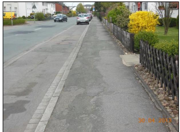
Abbildung 8: Mangelhafter Zustand des Gehweges und der Parkfläche; Quelle: Verfasser
