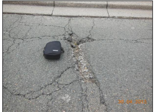
Abbildung 7: Zahlreiche leichte bis mittlere Schadstellen einschl. vereinzelt schwere Schadstellen; Quelle: Verfasser
