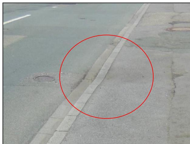
Abbildung 4: Absackungen im Bereich der Entwässerungsrinne einschl. geringes Fahrbahnlängsgefälle (Pfützenbildung); Quelle: Verfasser
