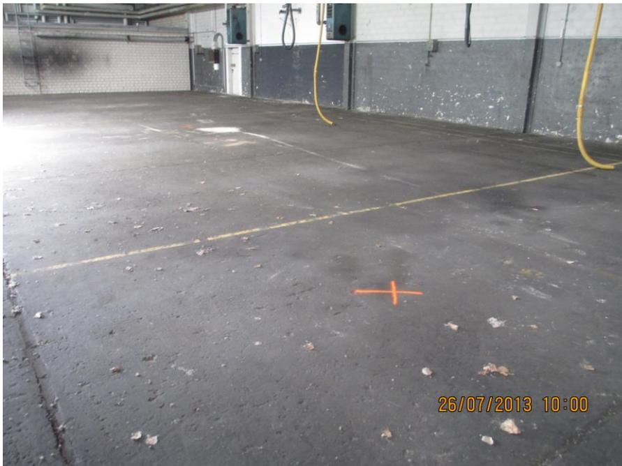
Foto 6: Halle (KVF 33) im Technischen Bereich Süd mit Kennzeichnung von Sondieransatzpunkten zur Eingrenzung einer Kontamination
