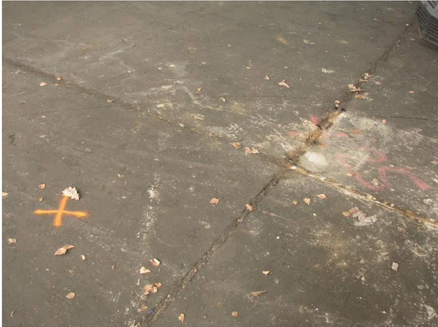
Foto 5: Lage der Sondierpunkte: links der Sondierpunkt aus der DU, rechts ehemaliger Sondierpunkt aus der OU dicht an die Fugen gesetzt (KVF 26)
