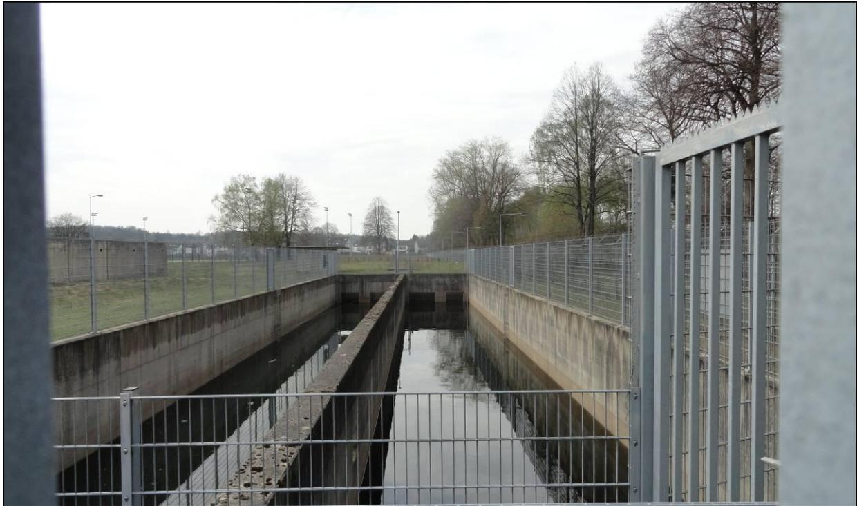
Abb. 21: Betonbecken des Regenrückhaltebeckens
