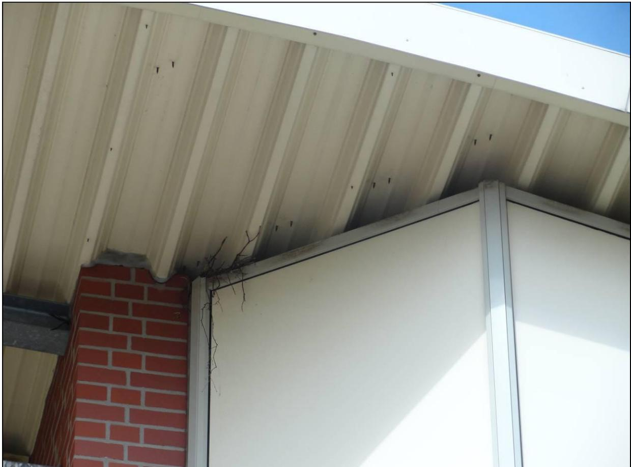
Abb. 7: Dachbereich an Gebäude Nr. 63 mit Dohlennestern
