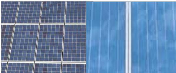
Beispiele: Photovoltaik (li.), Solarthermie (re.)
