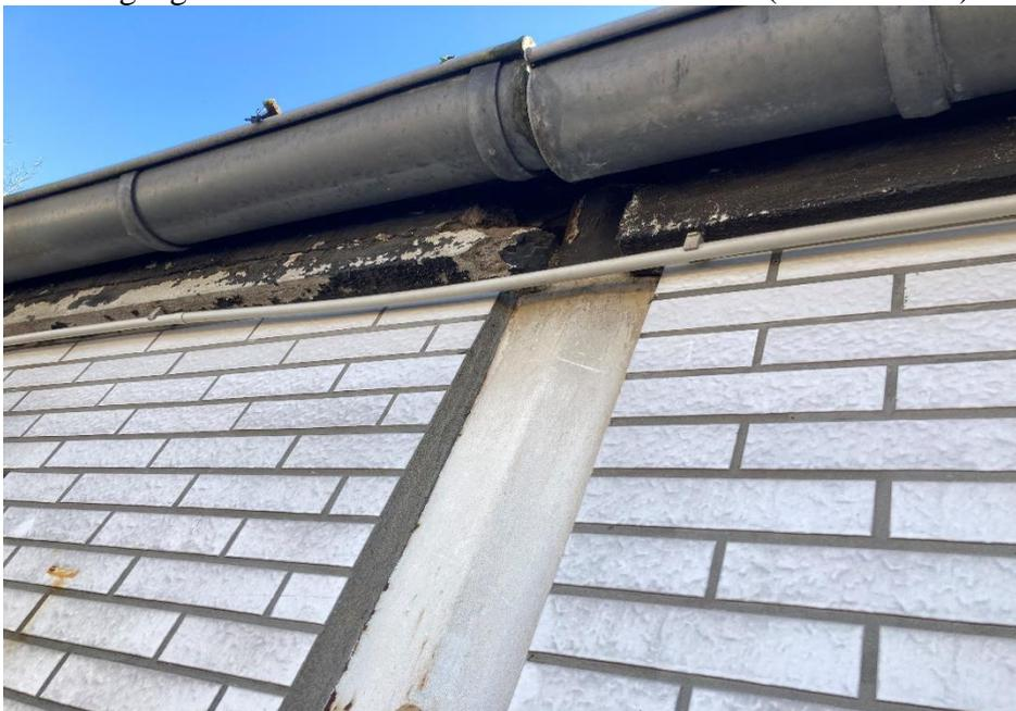
Abb. 2: Lücken in den Dachanschlüssen
