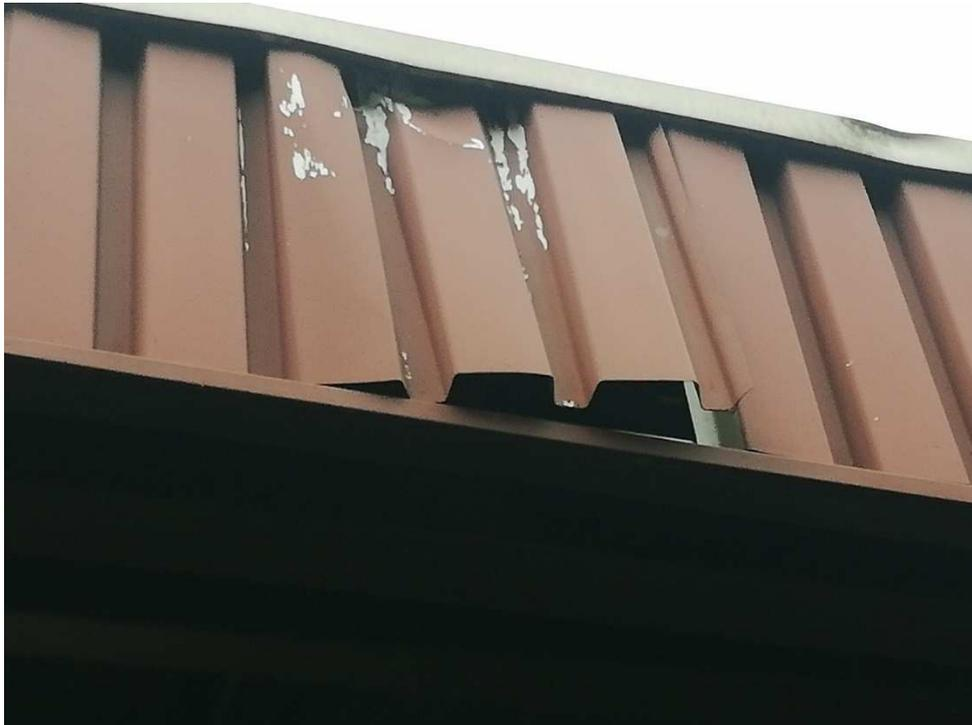
**Abbildung 7:** Abstehendes Trapezblech an Überdachung
