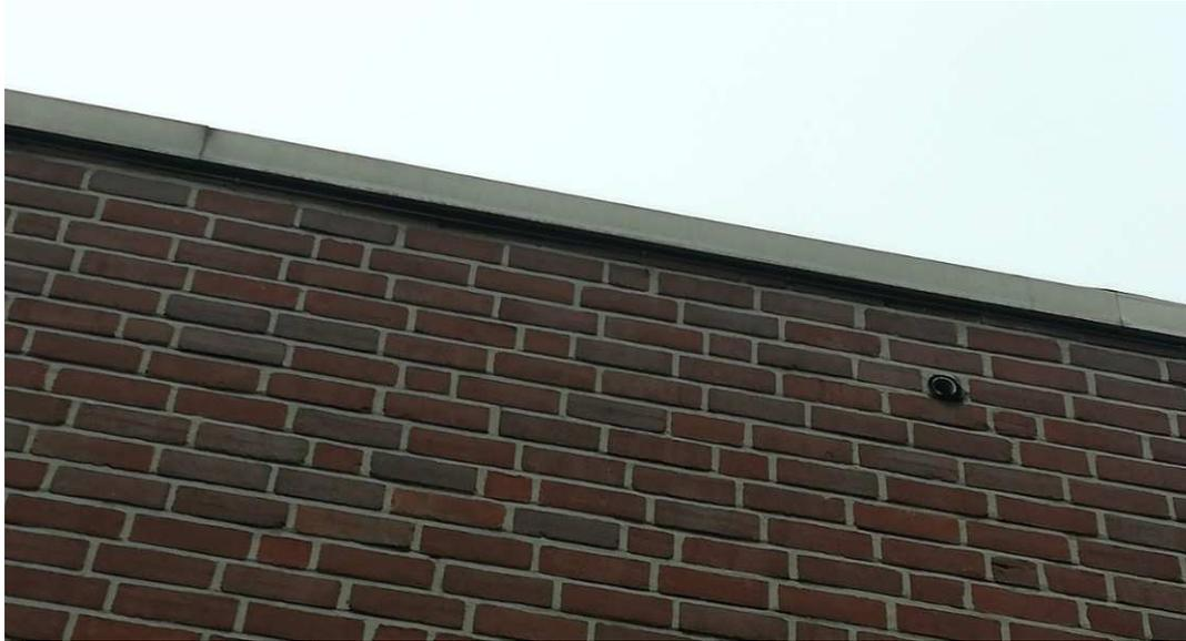
**Abbildung 6:** Spaltraum zwischen Traufblech und Fassade des Lebensmittelmarktes
