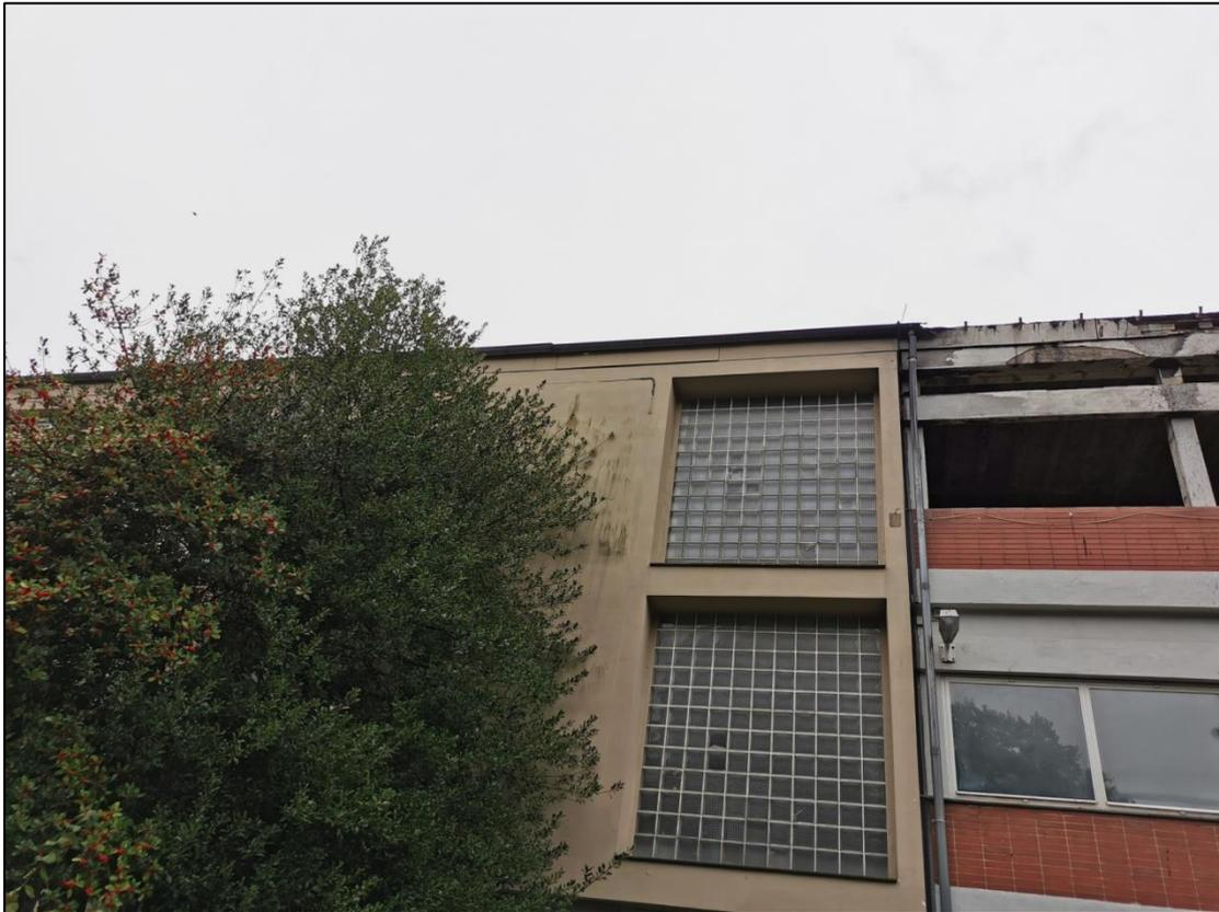
**Abbildung 8:** Schadhafte Stellen der Verblendung im Dachbereich (Nordosten)
