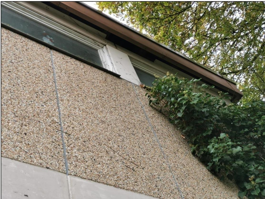
**Abbildung 7:** Schadhafte Stellen in der Verblendung im Dachbereich (Nordwesten)
