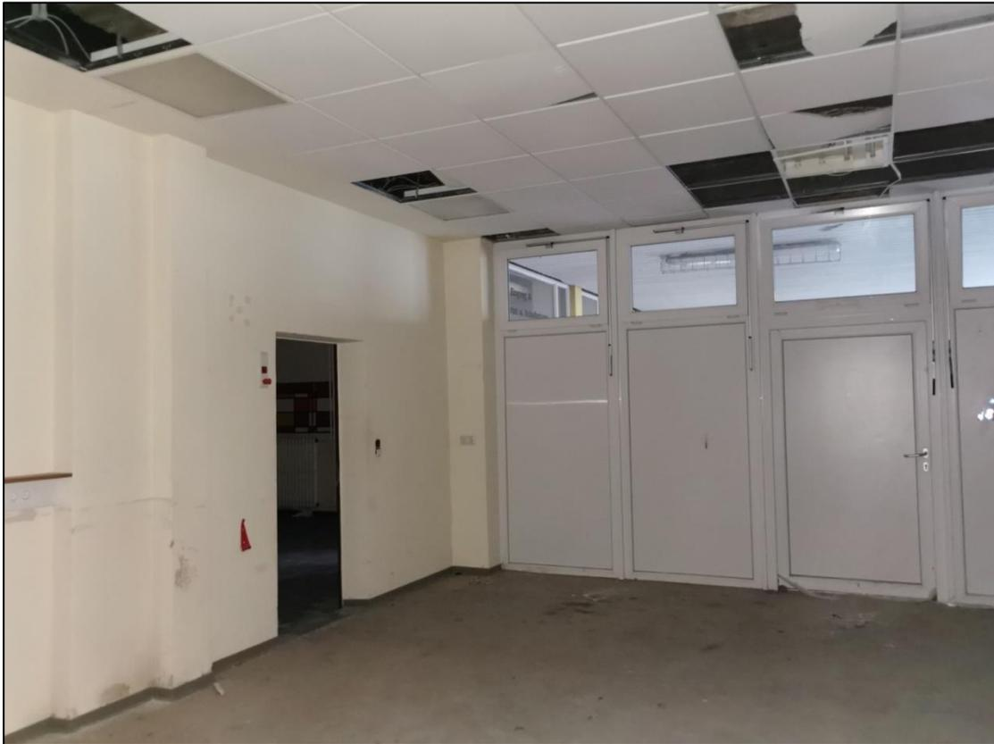
**Abbildung 10:** Ansicht Räume mit schadhafter Deckenverkleidung
