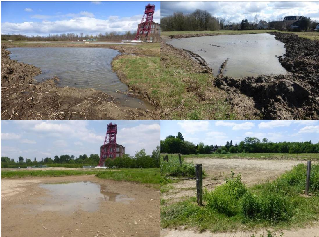
**Abb. 23:** Anders als ursprünglich geplant wurde am südwestlichen Rand der Rohbodenfläche ein etwas tieferes Gewässer (max. 50 cm) angelegt, das auch in Trockenwetterphasen einen Restwasserkörper halten sollte. Die im April 2015 (Fotos oben) noch sehr gute Wasserführung blieb aber in den Folgemonaten unbefriedigend (22.05. unten links, 10.06. unten rechts), weshalb die Bezirksregierung eine künstliche Abdichtung des Gewässers forderte.
