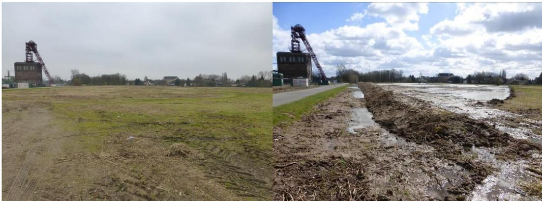
**Abb. 21:** Die Brachfläche Sterkrade im Dezember 2014 nach erfolgtem Rückschnitt von Gehölzen und Hochstaudenfluren und Ende März 2015, nachdem die Rohbodenfläche durch das flache Abschieben der Oberböden und deren Einbau in einer randlichen Verwallung hergestellt wurde.
