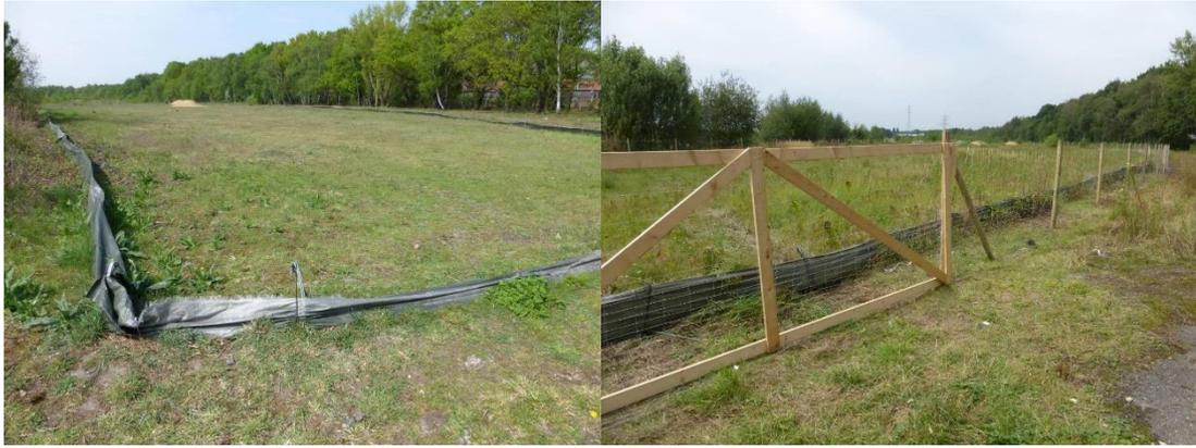
**Abb. 42:** Nachdem die Amphibienfangzäune wiederholt beschädigt wurden, erfolgte 2014 eine zusätzliche Sicherung mittels eines Wildschutzzaunes, die sich gut bewährt hat.
