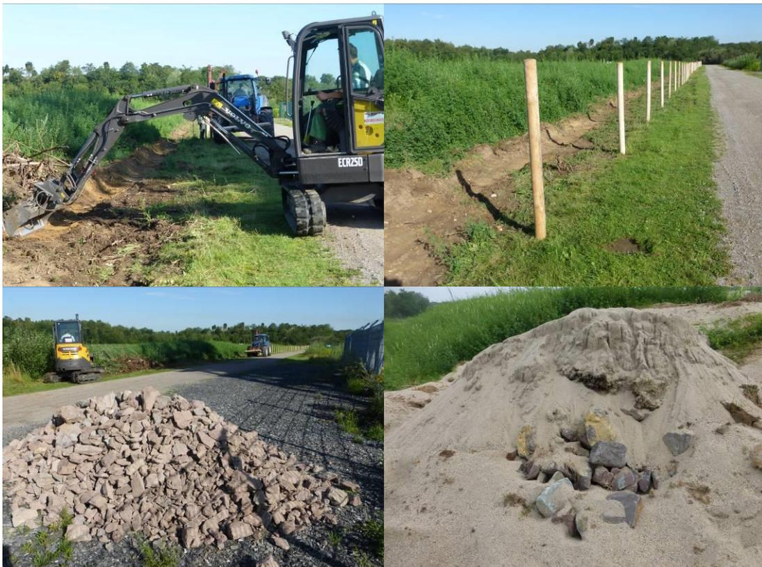
**Abb. 25: Anfang August wurde die Maßnahmenfläche mittels eines Forstzaunes von dem parallel verlaufenden Weg abgegrenzt, um Fußgängern mit Hunden den Zugang auf die Fläche zu erschweren. Randlich der Verwallung wurden weitere mit Sand überschüttete Steinpackungen als Winterquartiere für Kreuzkröten angelegt.**
