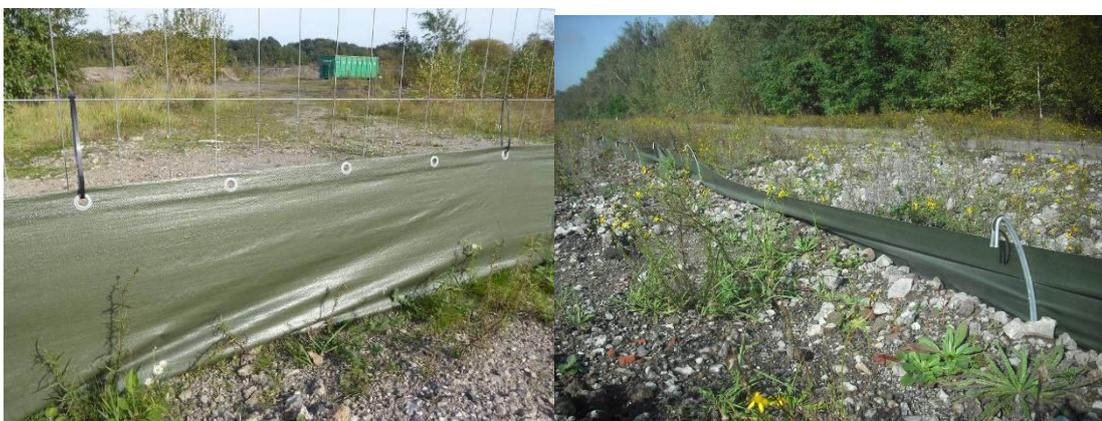
**Abb. 9:** Folienfangzäune mit eingearbeiteter Ösen-/Knopfleiste (links) haben sich gegenüber freistehenden Fangzäunen (rechts) sehr gut bewährt und können mittels Kabelbindern problemlos an den Baustellenzäunen befestigt werden.
