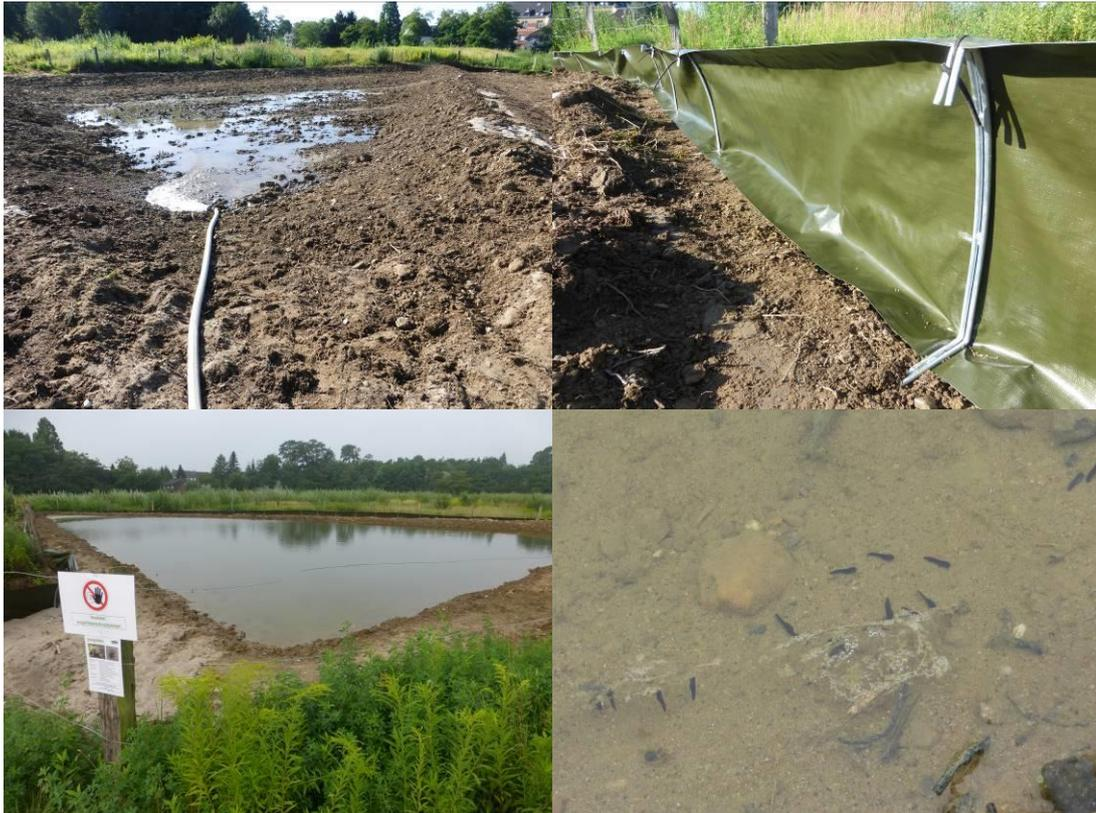
**Abb. 24:** Anfang August wurde das Kleingewässer daher mittels Teichfolie abgedichtet und geflutet. Parallel dazu wurde der Amphibienfangzaun errichtet. Nur wenige Tage später konnten erste Kreuzkrötenlarven in dem Gewässer entdeckt werden.
