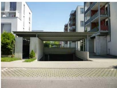
Grundsätzlich sollen die Zufahrten so schmal wie möglich gehalten werden. Sie sollten daher mit der Schmalseite zum öffentlichen Raum ausgerichtet sein. Bei kleineren Einheiten bietet sich eine Ampelregelung an, um die Zufahrtsbreite zu minimieren.
