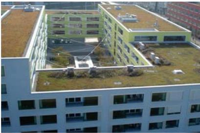
Zur Verbesserung des Stadtklimas und zur Minimierung notwendiger Retentionsflächen sind die Dächer der Geschosswohnungsbauten im Grundsatz flach, begrünt und ohne Dachüberstand auszubilden. Es wird die Verwendung von trockenheitsverträglichen Pflanzen in Kombination mit wasserspeichernden Mineralböden empfohlen.
