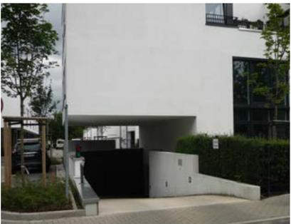
Tiefgarageneinfahrten sind grundsätzlich in die Gebäude zu integrieren, um lange Rampen im Außenraum zu vermeiden und die Nachbarn vor Lärm der ein- und ausfahrenden Autos zu schützen.
