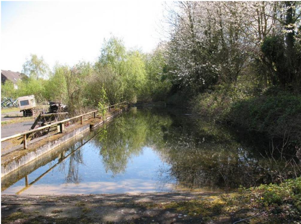
Die Panzerwaschanlage ist eine wassergefüllte Betonwanne mit seitlichen Steilufern, einer flachen Einfahrt vorne und Ausfahrt hinten (21.4.2016).
