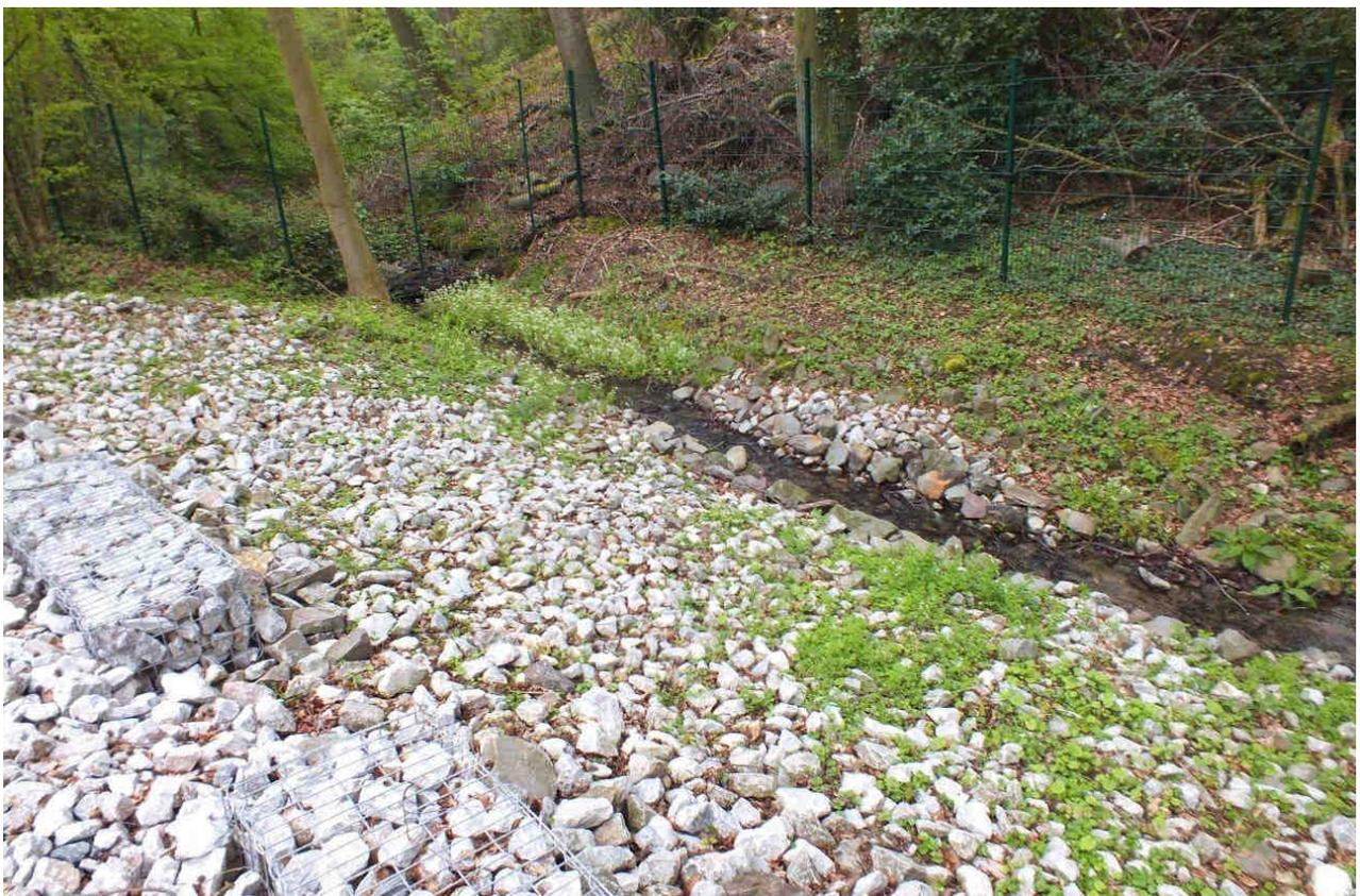
Foto 2: Überlauf des Regenrückhaltebeckens mit Gabionen, Steinschüttung und angrenzenden Hasselbach
