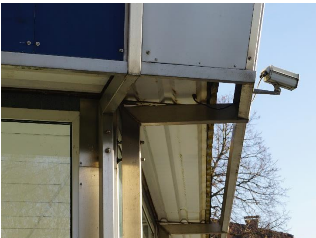
Abb. 3: Verkleidung der Dachkante des Autohauses (ISR 2021)
