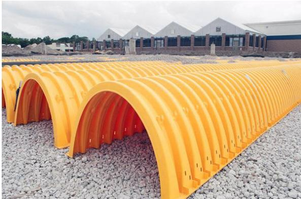
Bei Rigolen ist zu beachten, dass eine zusätzliche Reinigungsstufe erforderlich wird, da hier ja die Reinigung über die Bodenpassage entfällt. Als Reinigungsstufe ist zum Beispiel die Vorschaltung eines Filterschachtes denkbar.
