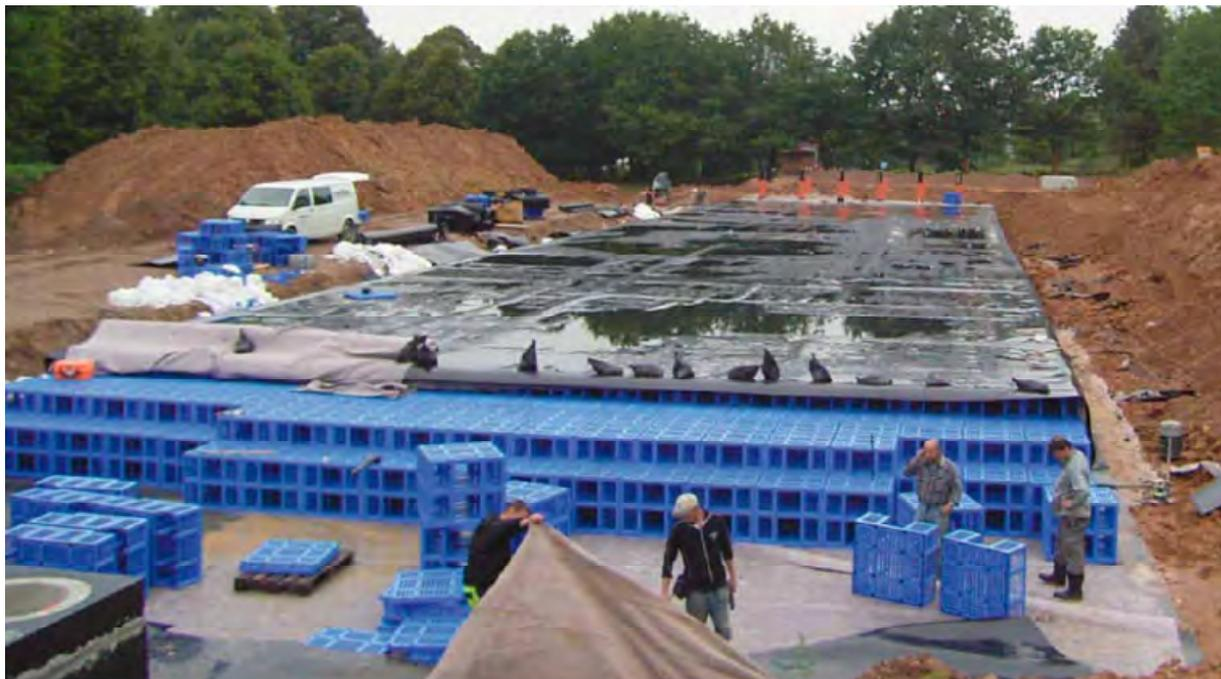
Abbildung 1: Unterirdische Rückhaltung durch Speicherboxen
