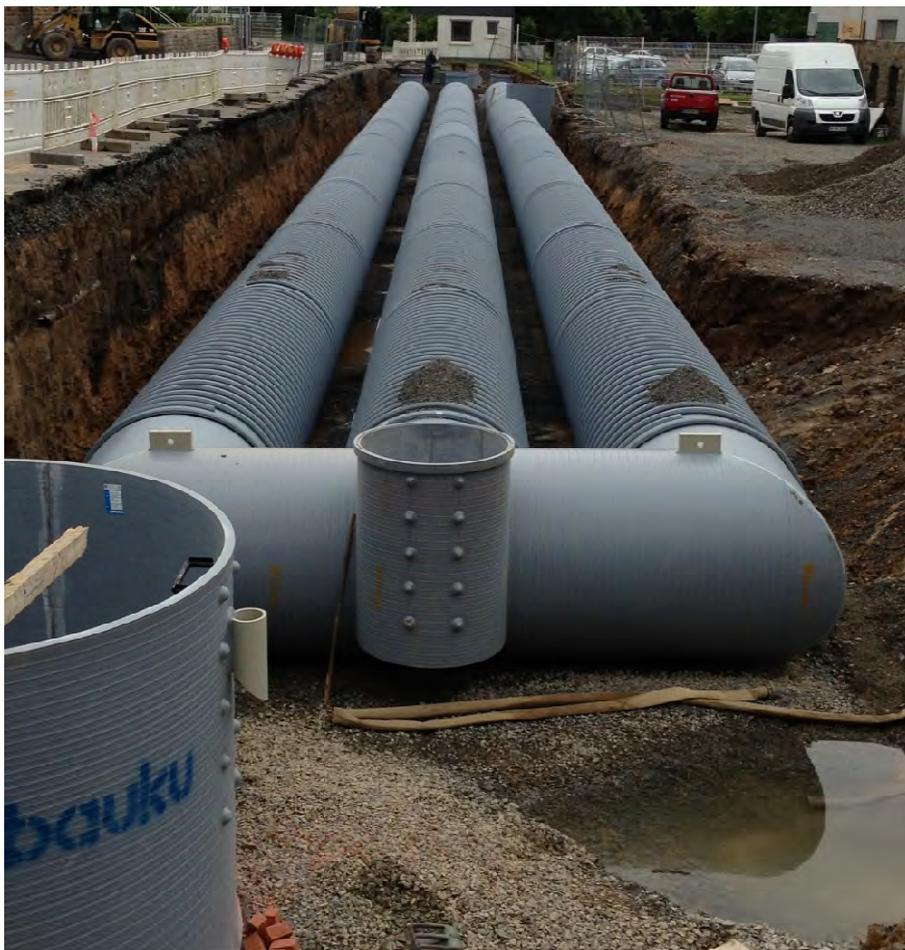
Abbildung 2: Unterirdische Rückhaltung durch Staukanäle
