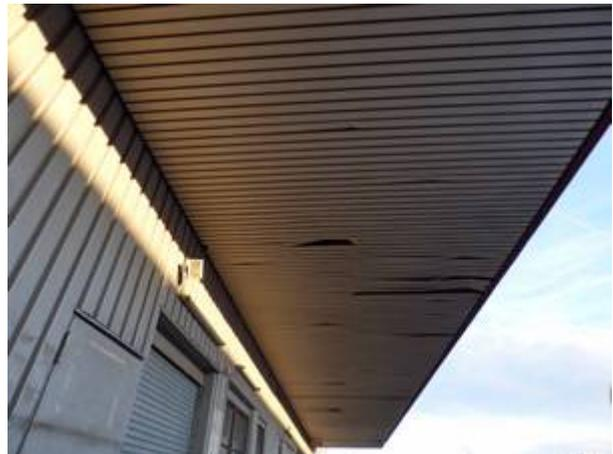
**Abbildung 8:** Schadstellen an der Dachunterseite über der Laderampe.
